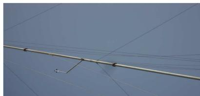
4. Vérification de la verticalité du tube de base du mât à l'aide d'un **niveau à bulle** et ajustement de la tension des haubans
