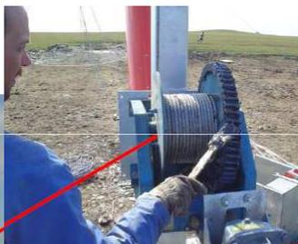
2. Contrôle et ajustement permanent de la tension des haubans
