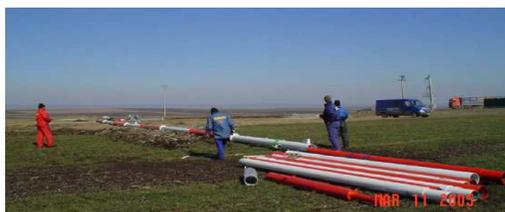
3. Insertion d'un fil de fer à l'intérieur du mât pour éventuellement tirer le câble électrique
